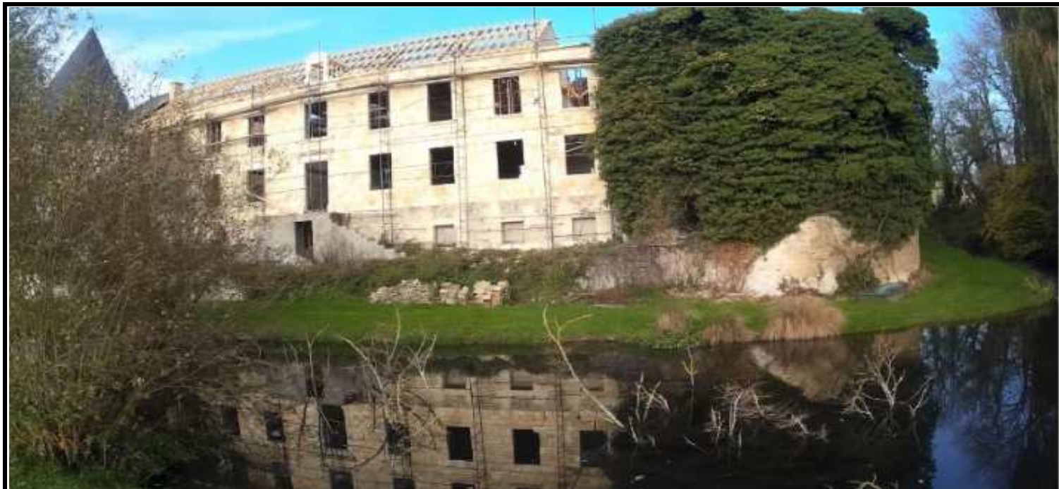
Pose des chevrons de la toiture sud du château et reflet dans les douves
